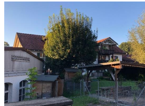
Aufnahme hinterliegende Gebäudeteile (Quelle: NRP Ingenieure, Sept. 2020)
