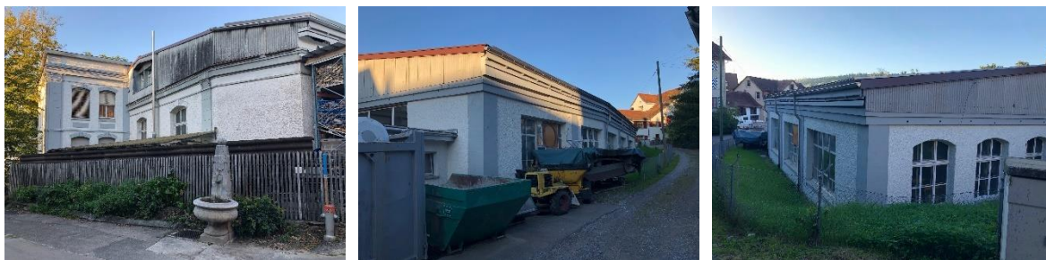
Aufnahme hinterliegende Gebäudeteile (Quelle: NRP Ingenieure, Sept. 2020)
